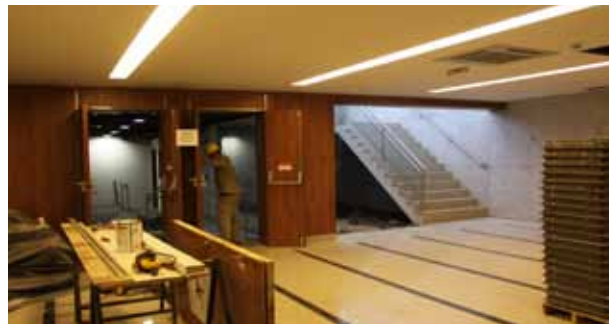
COLOCAÇÃO DAS DIVISÓRIAS NO NOVO PRÉDIO.
