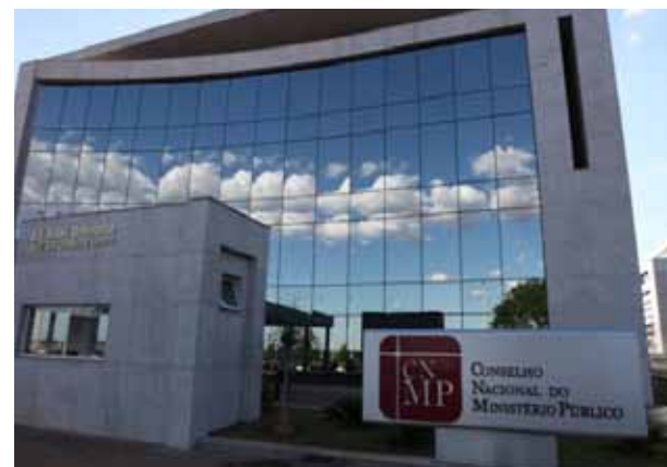
ATUAL PRÉDIO DO CNMP.
